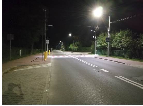
Doświetlenie przejścia dla pieszych ul. Szkolna w Starachowicach - DP 1811 T (0907T)
